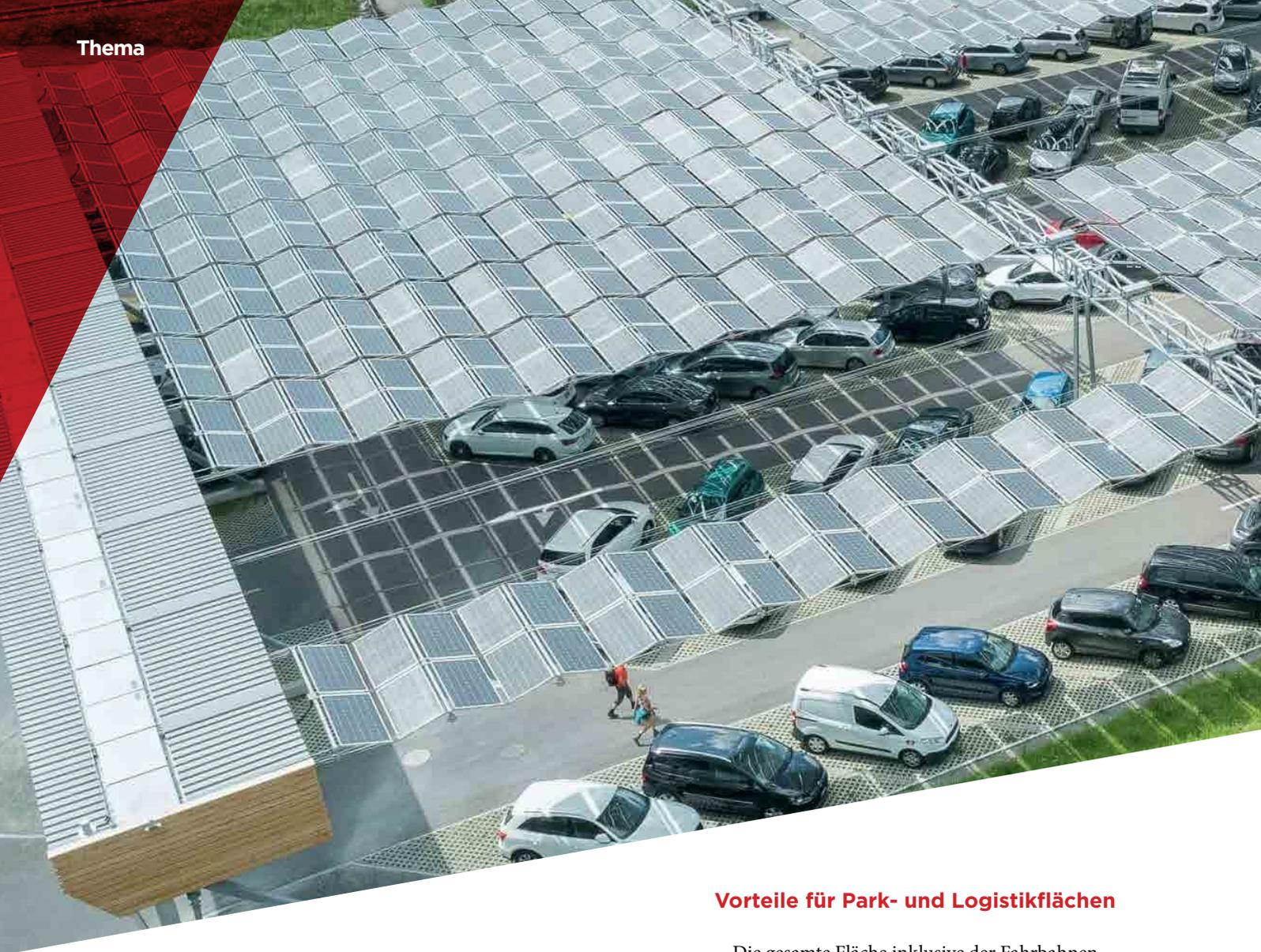
Module und weisen ebenfalls identische Leistungsdaten auf. Im Vergleich zu einem Glasmodul mit einem Gewicht von 20 bis 25 Kilogramm wiegt das Leichtmodul lediglich 7 Kilogramm. Eine Blendwirkung bleibt zudem aus und erlaubt damit die Sonnenschutzfunktion des Faltdaches in hochtemperierten Gebieten. Die beweglichen Bauteile sind aus rostfreiem Stahl oder Spezialkunststoffen gefertigt; verzinkter Stahl mit einer zusätzlichen
